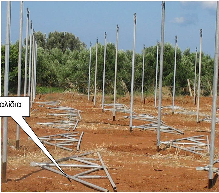
Οι στύλοι θα συνδεθούν μεταξύ τους είτε με «ψαλίδια» (όπως φαίνεται στην φωτογραφία), είτε με ενδιάμεσο στύλο, ώστε να σχηματιστεί η κατασκευή πυραμίδας
