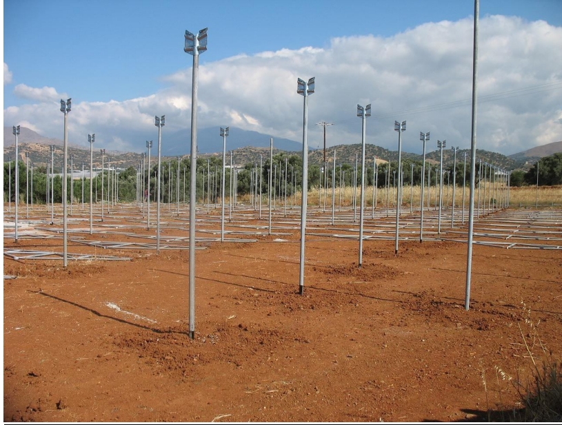
Αρχικό στάδιο κατασκευής θερμοκηπίου: έχει πραγματοποιηθεί η πάκτωση στύλων στο έδαφος
